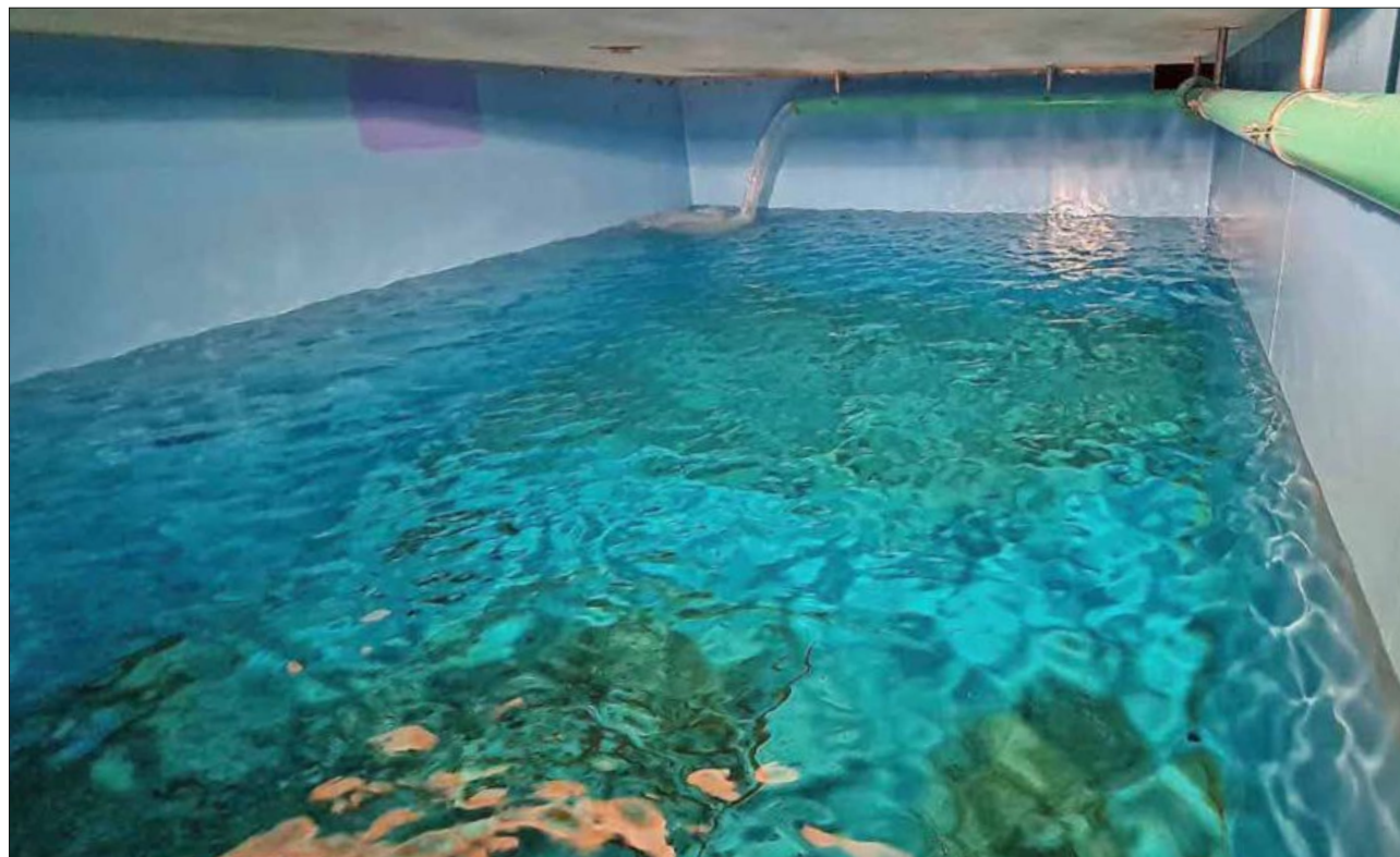
So sieht die Rohwasserkammer des Hochbehälters Radschert aus.
