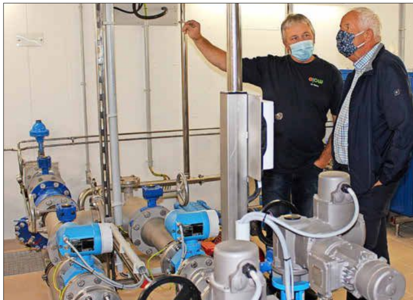
Walter Maier (links) erläutert Rainer Stickelberger den Weg des Wassers im Hochbehälter Radschert in Todtnau.
